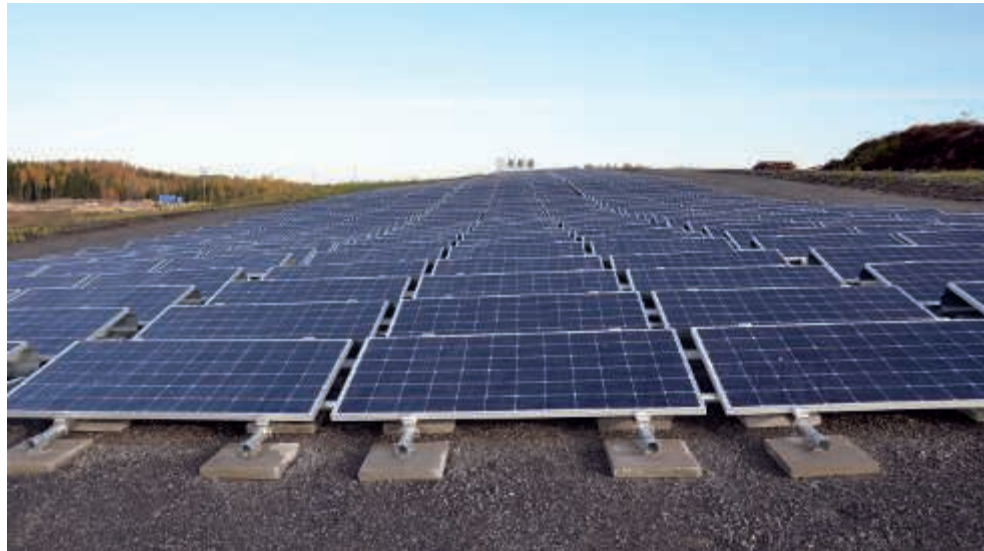
Jätekeskukselle suljetun jätetäytön päälle rakennettiin aurinkovoimala.
