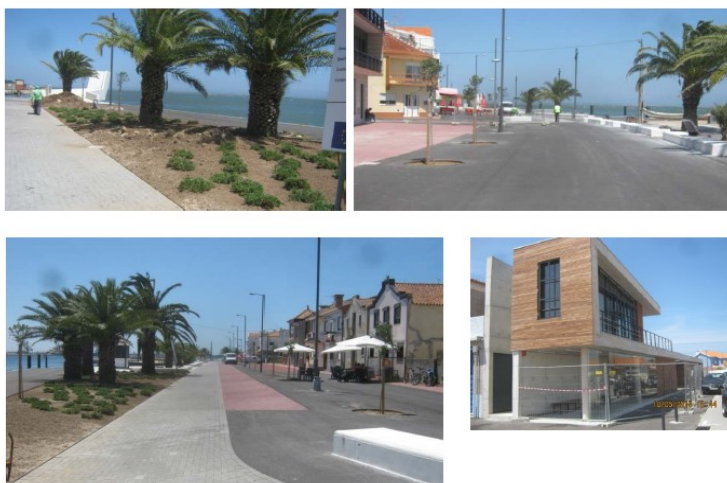
Figura 59 - Execução da Intervenção Polis Fonte: Ria de Aveiro Polis Litoral, Execução do Polis Ria de Aveiro, J. Correia de Almeida, 28 de maio de 2015
