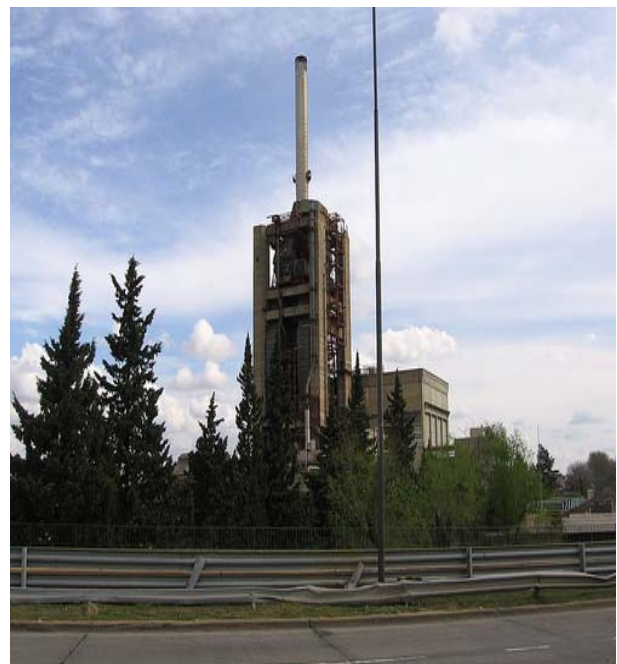
Central Térmica Sorrento (Rosario, Sta Fe)
