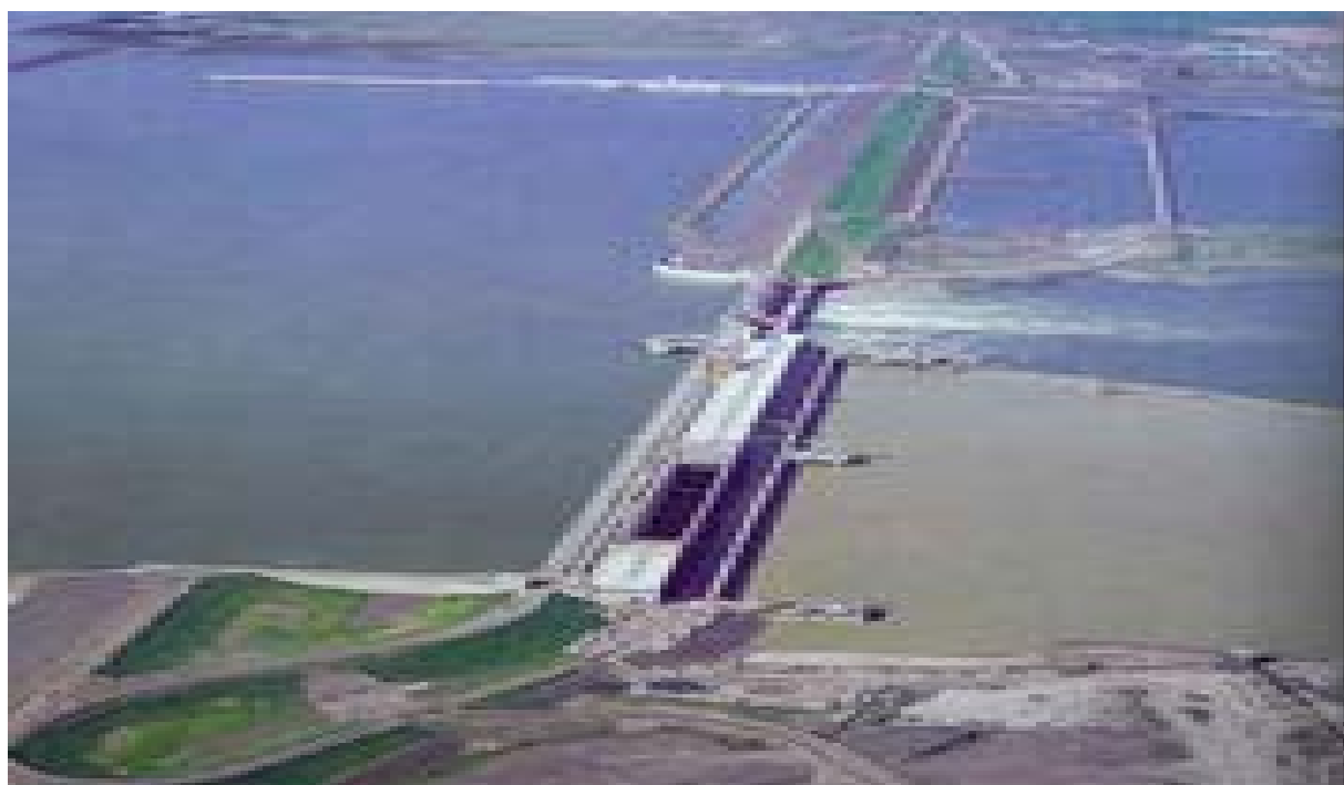
Central hidroeléctrica binacional argentino-paraguaya Yacyretá
