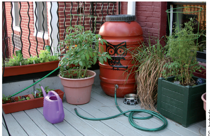
Déconnexion de gouttière, États-Unis
