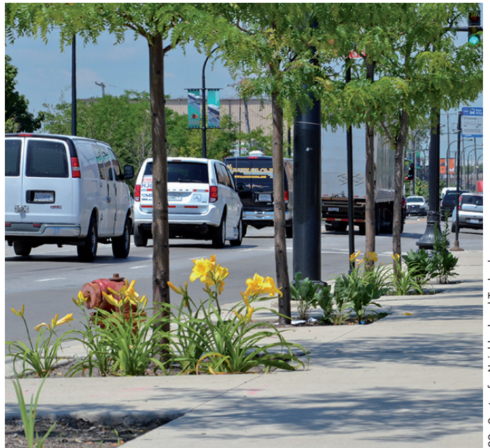
Revêtements perméables combinés à des espaces plantés décaissés, Chicago
