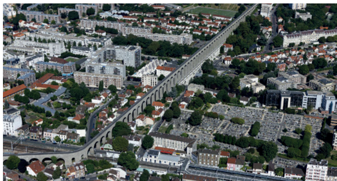
Le pont-aqueduc (aqueduc de la Vanne) à Arcueil
