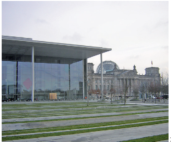
Désimperméabilisation du sol d'un grand parvis, Berlin
