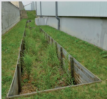
Noue des eaux de toitures
