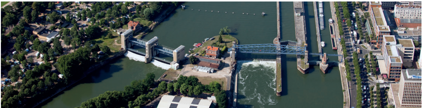
Barrage-écluse de Suresnes
