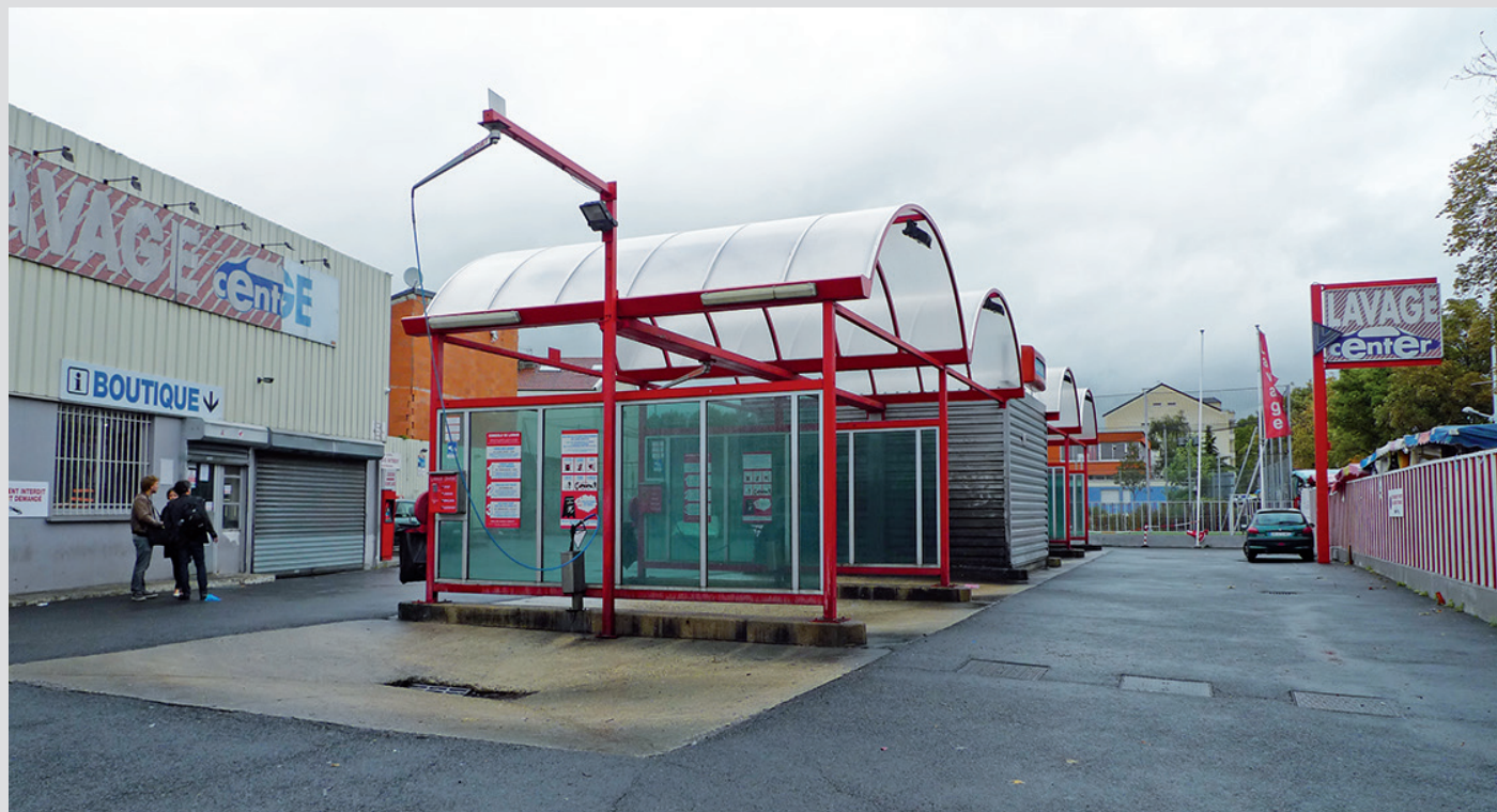
Vue d'ensemble du lavage Center
