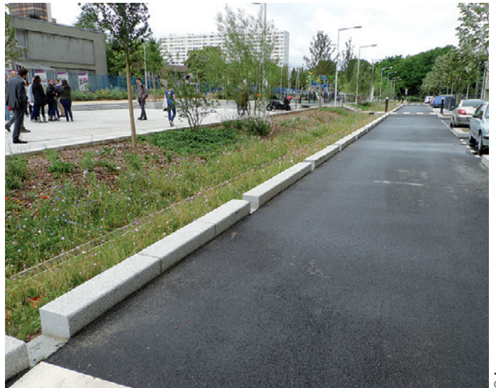
Espace planté recueillant les eaux de chaussée, les 4 000, La Courneuve
