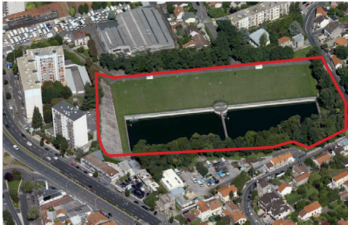
Réservoir de Villejuif
