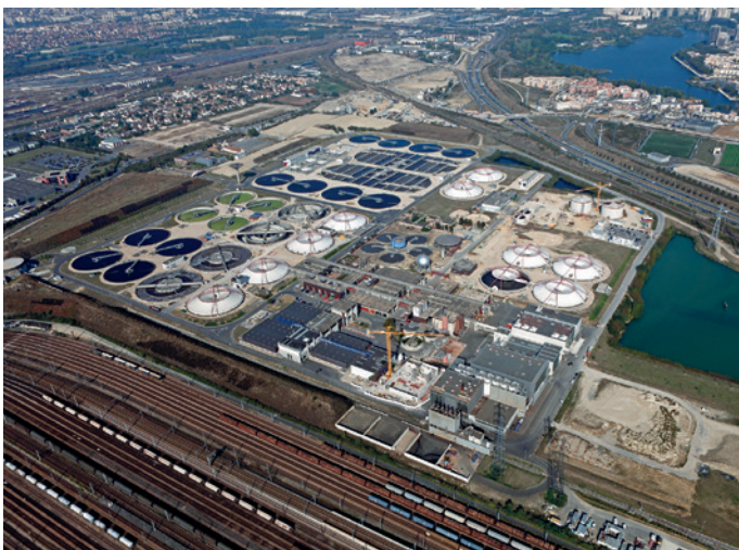
© ph.guignard@air-images.net Station d'épuration de Valenton
