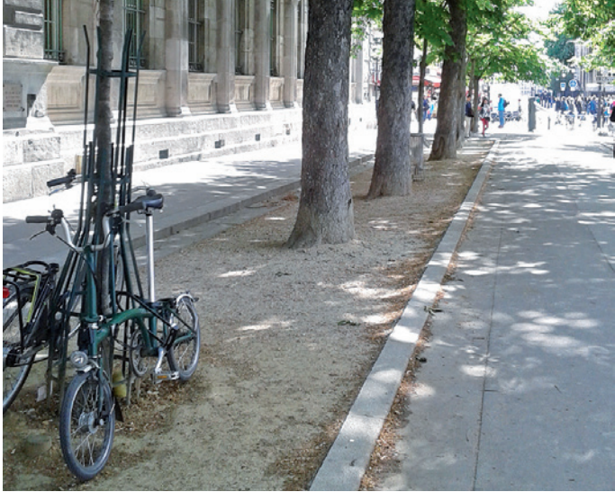
Tranchée continue avec bordure, Paris 4 e
