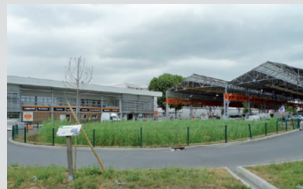
Bassin de récupération des eaux de voiries
