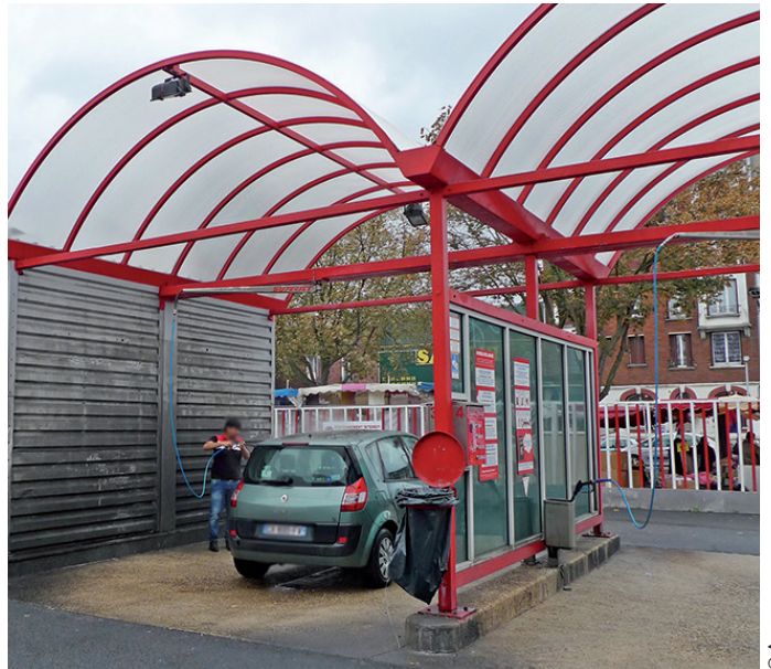
Lavage Center, La Courneuve
