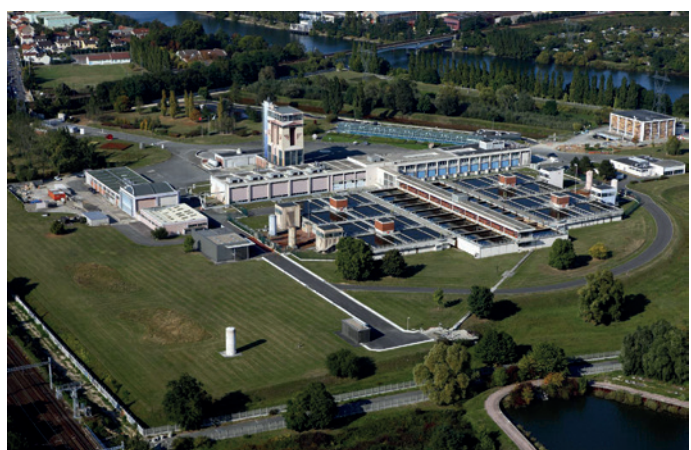
La Centrale de Stérilisation d'Eau de la Ville de Paris à Orly
