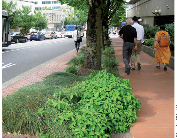
Tranchée continue recueillant les eaux pluviales, Portland
