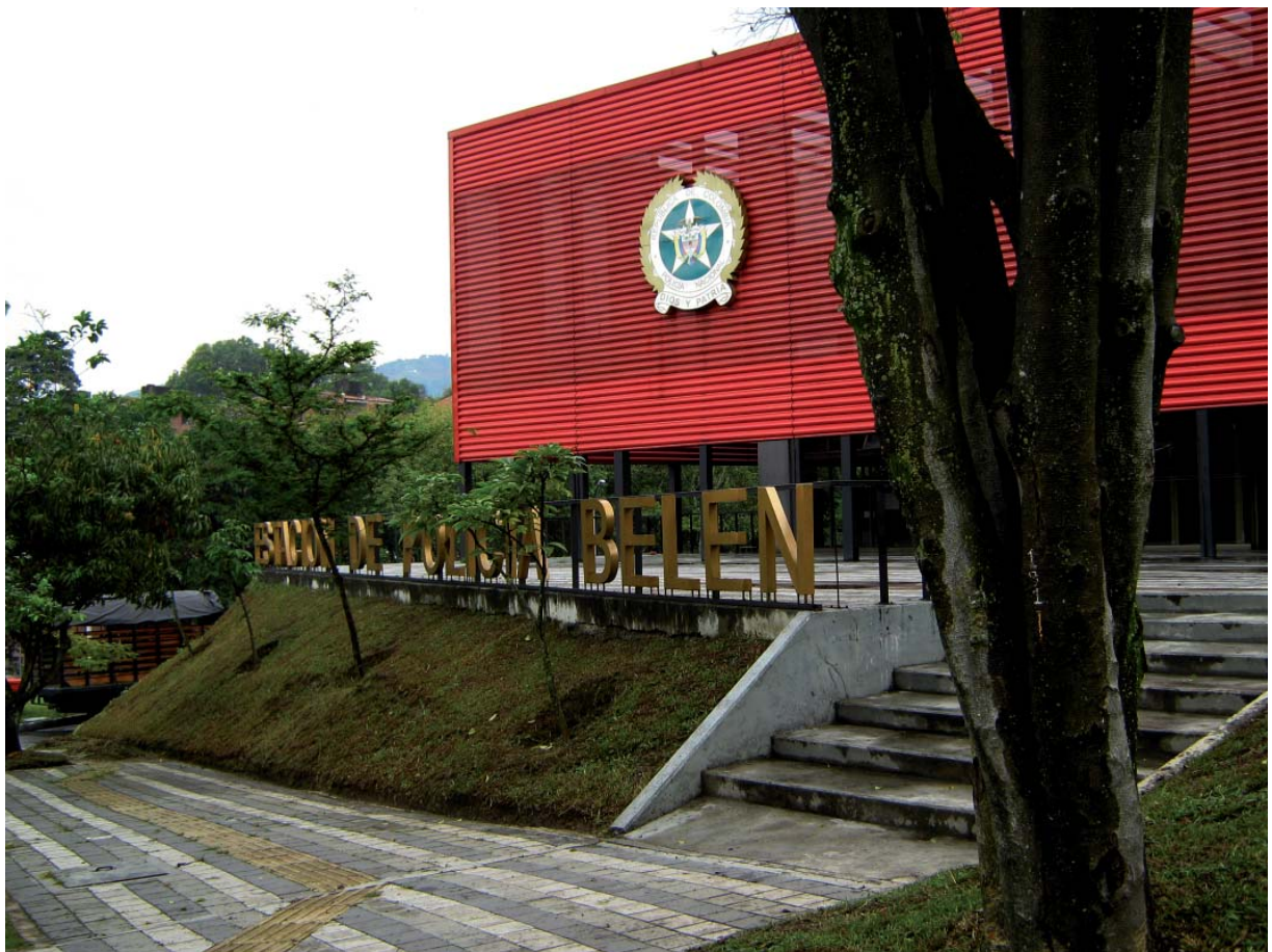
Figura 2.12 Estación de Policía en el barrio Belén Fuente: Grupo UR
