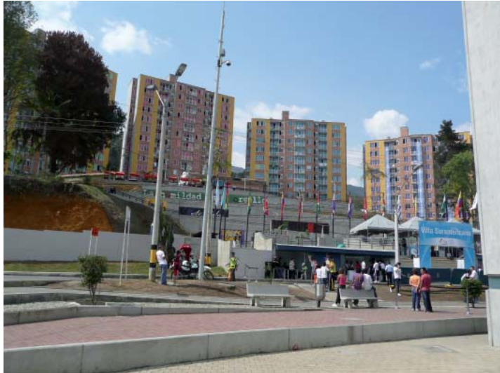
Figura 2.17 Plaza de llegada del Metrocable Nuevo Occidente - Villa Suramericana Fuente: Confama
