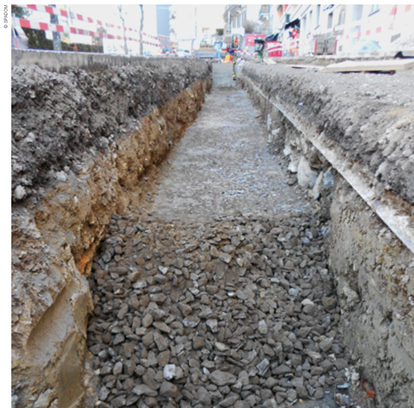
Mélange terre-pierre mis en place.
